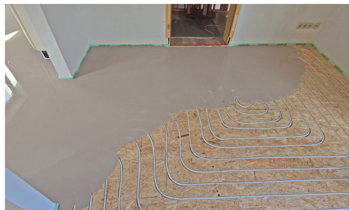
Zügiger Baufortschritt möglich
