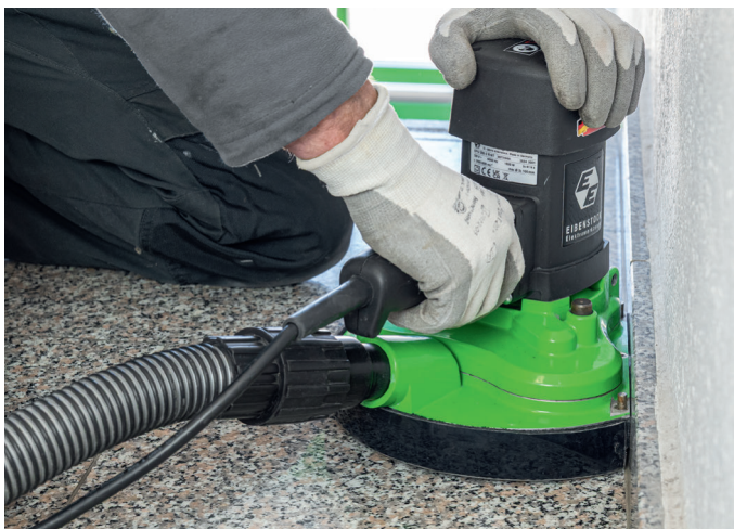
Polierarbeiten bis unmittelbar an die Kante möglich
