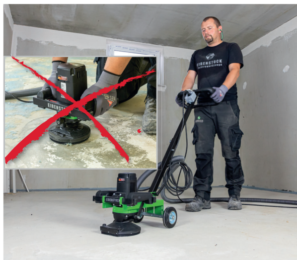
Rückschonendes Arbeiten mit Bodenführungsgestell
