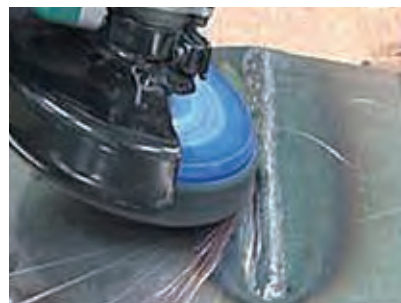
*odstraňovanie farebných defektov po zvaroch
